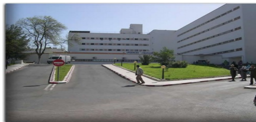
Hôpital Mohamed V à Meknès
